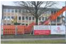
Die Abbrucharbeiten sind in vollem Gange. Foto: Philippsen
